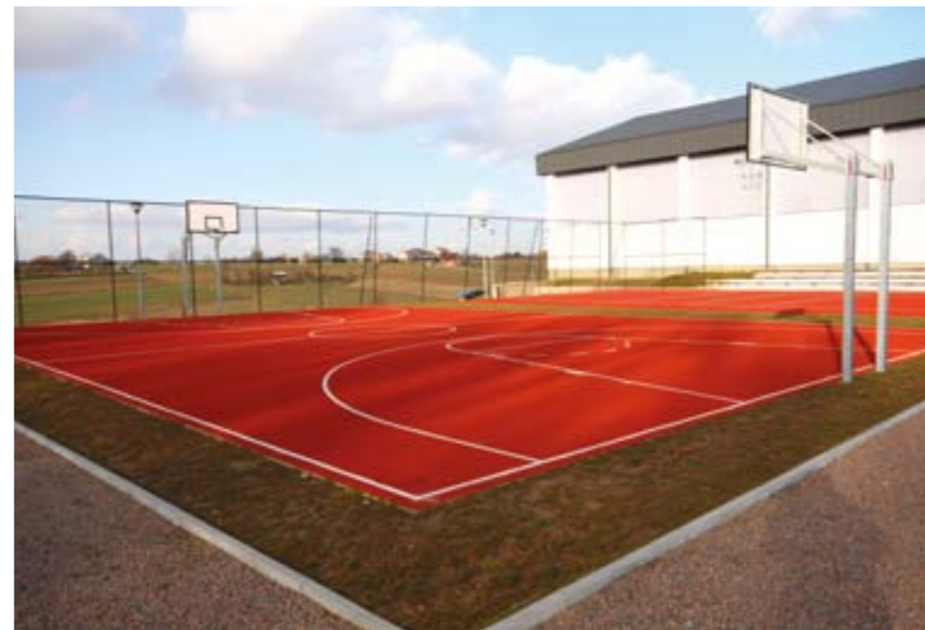
Obiekt: Boisko Sportowe przy Hali Widowiskowo- Sportowej ul. Ks. S. Połętka 34, 32-043 Skała
